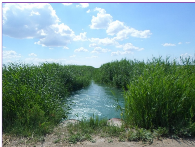
Фото 1.5.1 – Заращение тростником и камышом канала Рх-4-6-2
