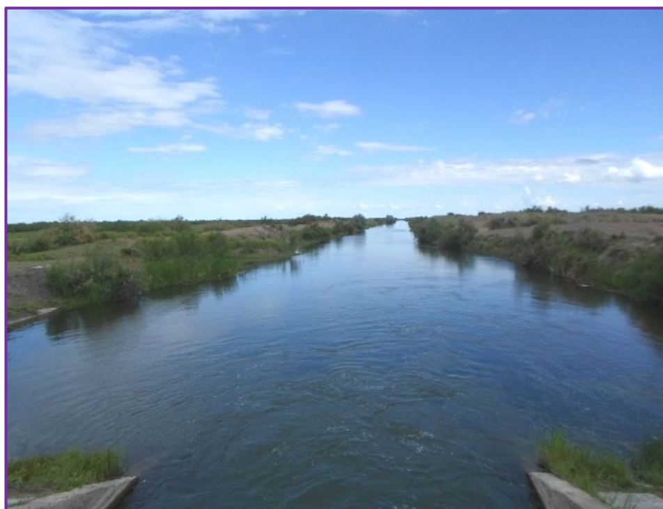
Фото 1.6.1 – Современное состояние Главного коллектора ниже К-6 и в концевой части Акдалинского сельского округа
